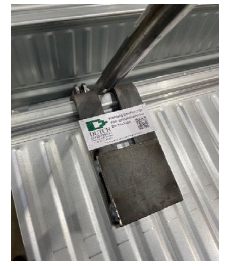
Zijoverlap - klemmen met Klemtool h.o.h. 1500 mm | Daarna schroeven met parkers h.o.h. 350 mm
