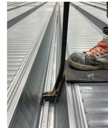
Zijoverlap - klemmen met Klemtool h.o.h. 1500 mm | Daarna schroeven met parkers h.o.h. 350 mm
