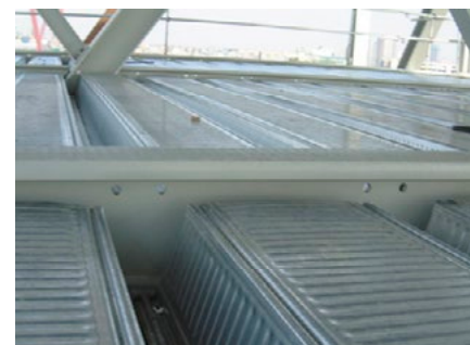
Doorvoeren koppelwapening bij uitvoering volgens Detail 2.
